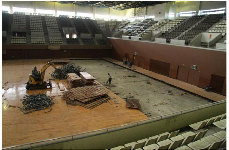
11月28日(水)の第1競技場の様子です。床板が全て撤去されコンクリートのみとなりました。所々に見える四角い穴は、バレーボール等の支柱部分です。
